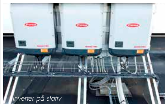
Inverter på væg
